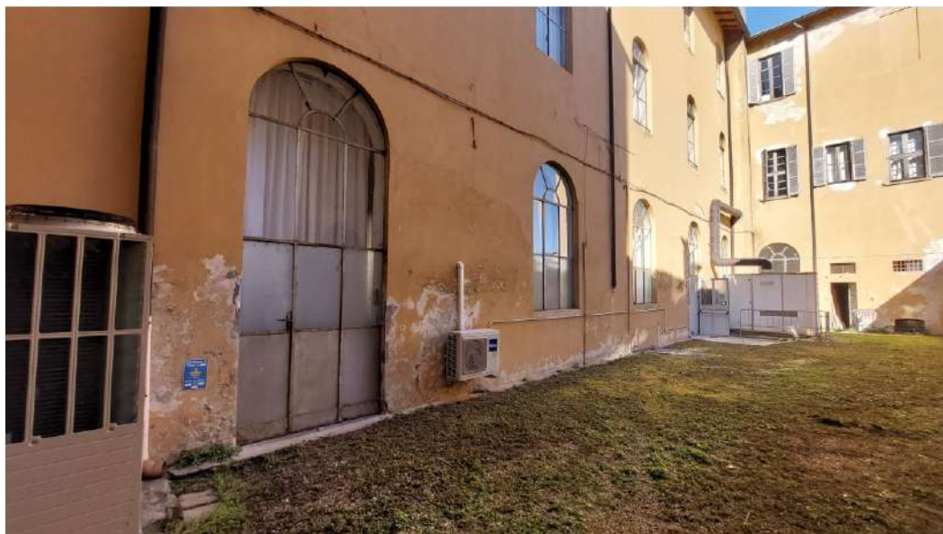
3 CORTILE OGGETTO DI RIPRISTINO
