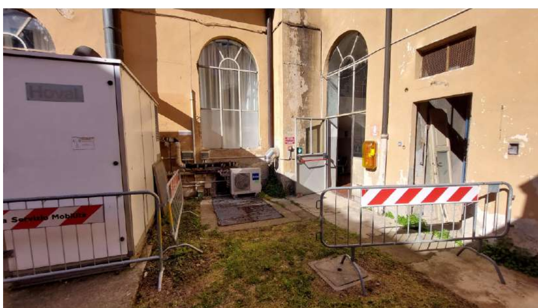
5 CORTILE OGGETTO DI RIPRISTINO
