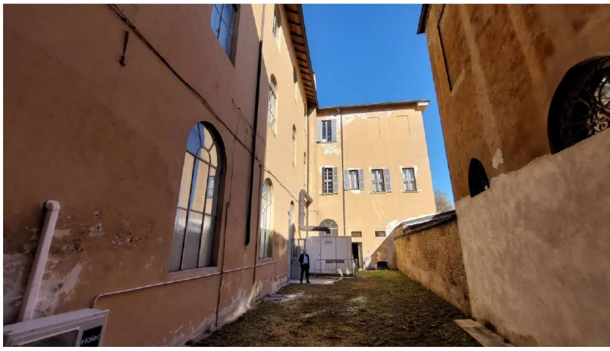
1 FACCIATE OGGETTO DI RIPRISTINO INTONACI
